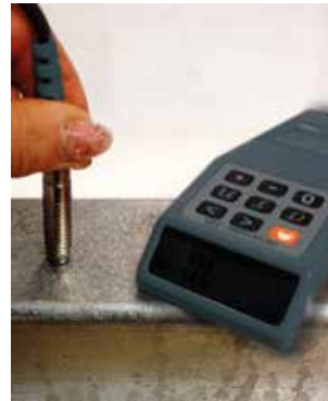
Kuva 9-1. Sinkkikerroksen paksuus mitataan magneettisella menetelmällä.
